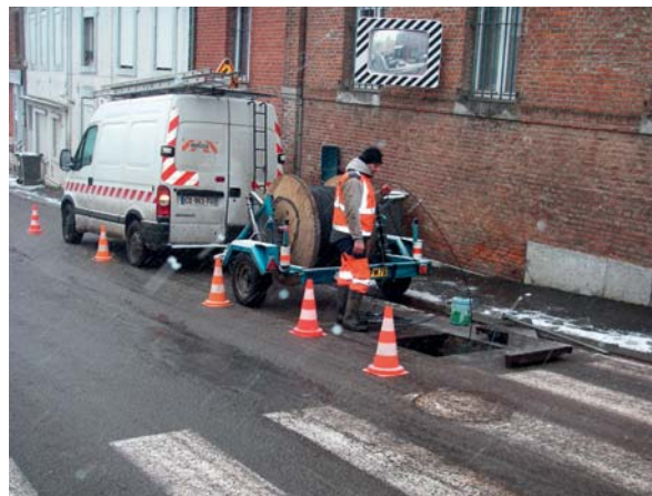
• Rue Clémenceau La fibre arrive et s'installe - février 2018
