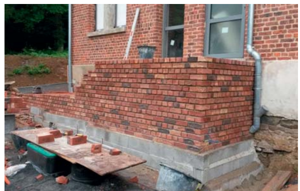
• Logement communal Quartier de la Galoperie Assainissement non-collectif, accessibilité... tout aux normes. Isolation. Performance énergétique – mai 2018
