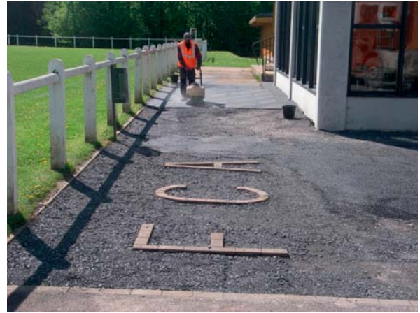
• Club-house du Stade La finition avec la pose de l'enrobé - mai 2018
