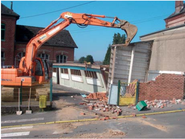
• Le « 36 » (Ancienne école maternelle) Les travaux ont commencé – mars 2018
