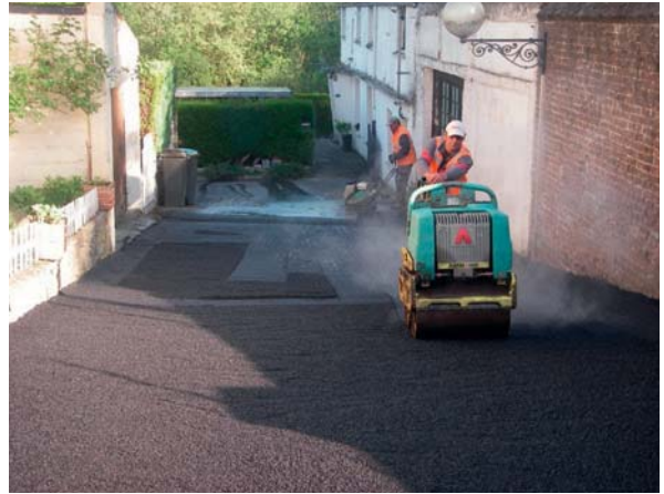
• Impasse – Place du Fort Réfection totale de la voirie - mai 2018
