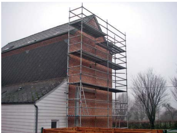
• Ancienne Ecole du Point du Jour Sablage, rejointoiement par le service insertion de la CCSA - janvier 2018
