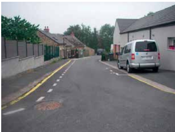
• Rue du Petit Canton - Impasse Marquage au sol après réfection de la voirie - octobre 2017
