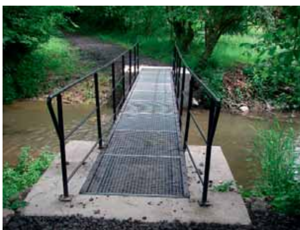
• La nouvelle passerelle posée par les services techniques Mai 2019 La Vieille Verrerie
