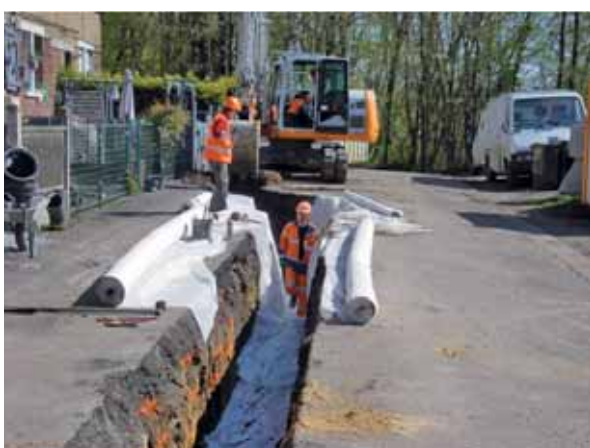
• Travaux d'assainissement NOREADE réalisés par l'entreprise STPA – Avril 2019 Quartier de la Galoperie
