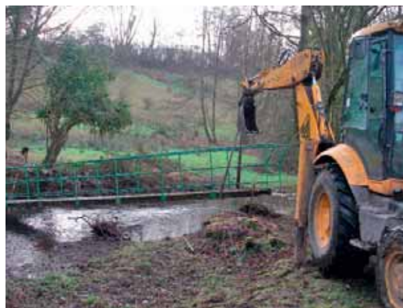
• L'ancienne passerelle déposée par le Service Technique Février 2019 La Vieille Verrerie
