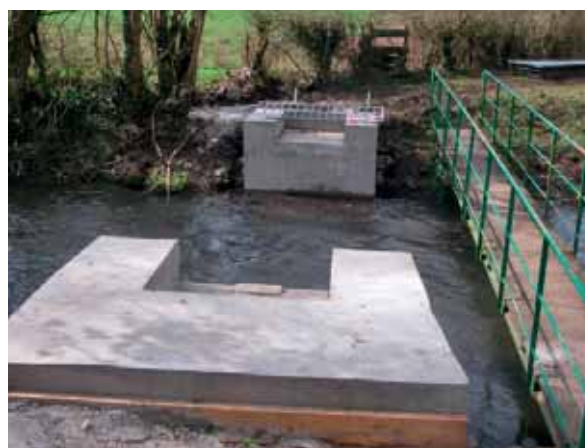
• Réalisation des massifs pour la nouvelle passerelle – Mars 2019 La Vieille Verrerie
