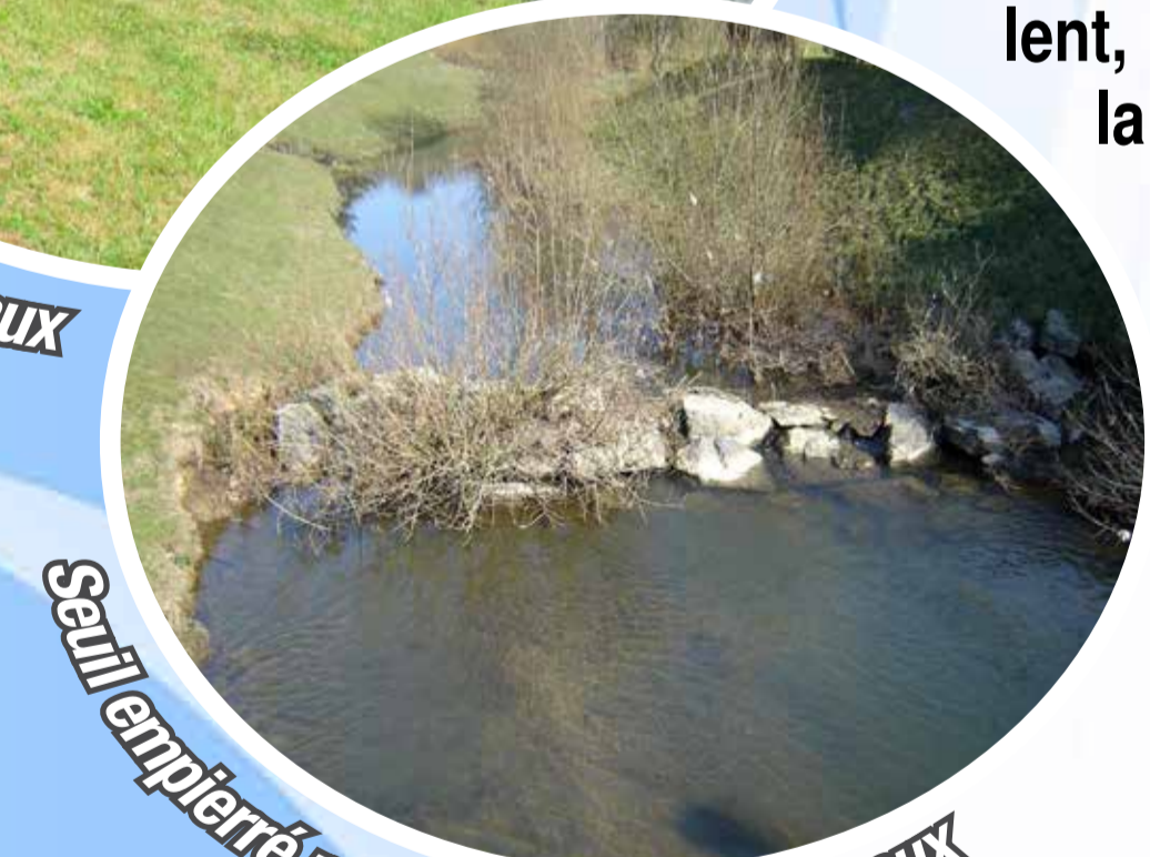
Le ru des Anorelles après les travaux
